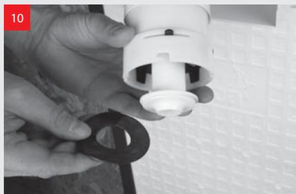
10 Снимите уплотнение из прореза сливной трубки. Очистите или замените уплотнение и в обратной последовательности поставьте обратно.
