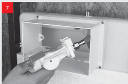
7 Вытяните напускной механизм. Нажмите на верхний стопор и потяните клапан вверх. Наклонив в сторону, удалите его из резервуара.
