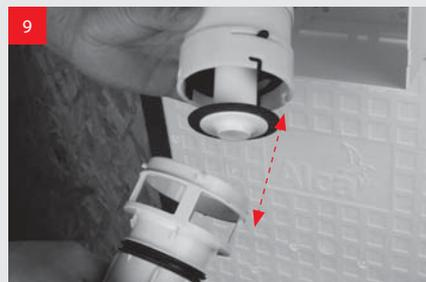
9 Снимите нижнюю часть сливного механизма, повернув её слегка вправо.
