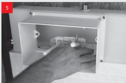
5 Вытяните механизм. Легким нажатием с двух сторон ослабьте механизм и вытяните его из пазов, вырезанных в кромке бачка.
