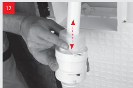
12 Движением малого поплавка на трубке можно регулировать объем малого смыва: движением вверх – объем воды уменьшается, вниз – увеличивается.
