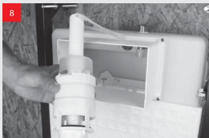
8 Вытяните сливной механизм. Осторожно потянув вверх и легко расшатывая влево и вправо, освободите его от зафиксированного положения. После чего наклоните выпускной механизм в сторону и аккуратно удалите из резервуара.
