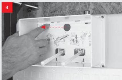
4 Снимите внутреннюю пластину. В верхней части нажмите на страховочный стопор, надавите и снимите панель потянув ее на себя.
